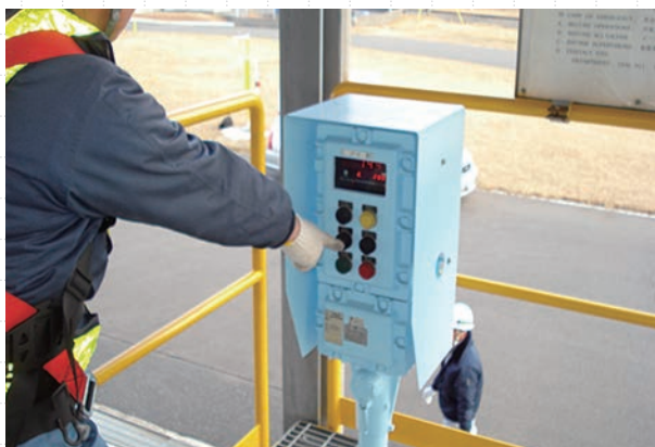
【出荷設備試運転】
