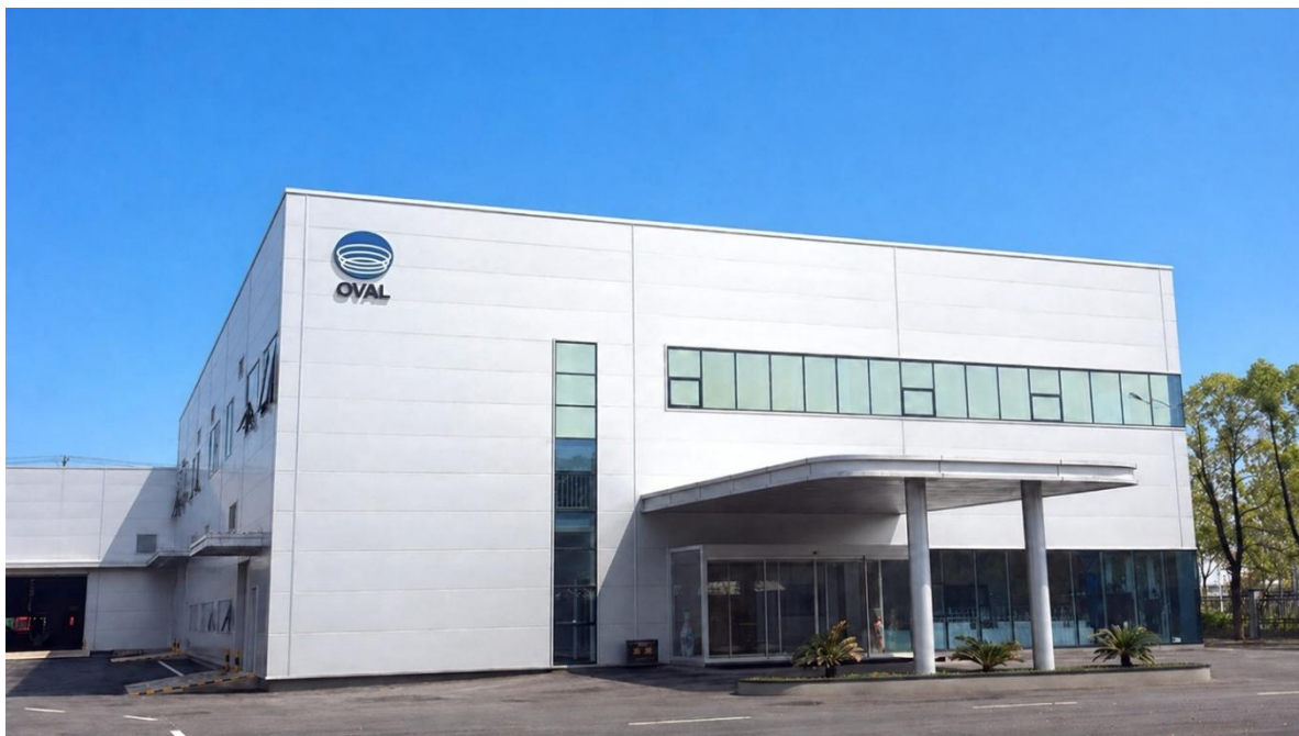
合肥オーバル 新工場 外観
