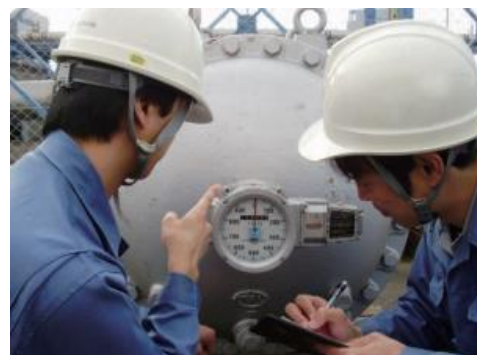
現地での修理・メンテナンス
