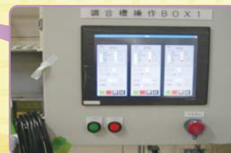
現場制御・監視盤
