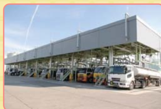
ローリー出荷設備
