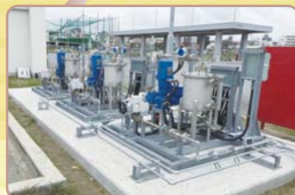
燃料添加設備
