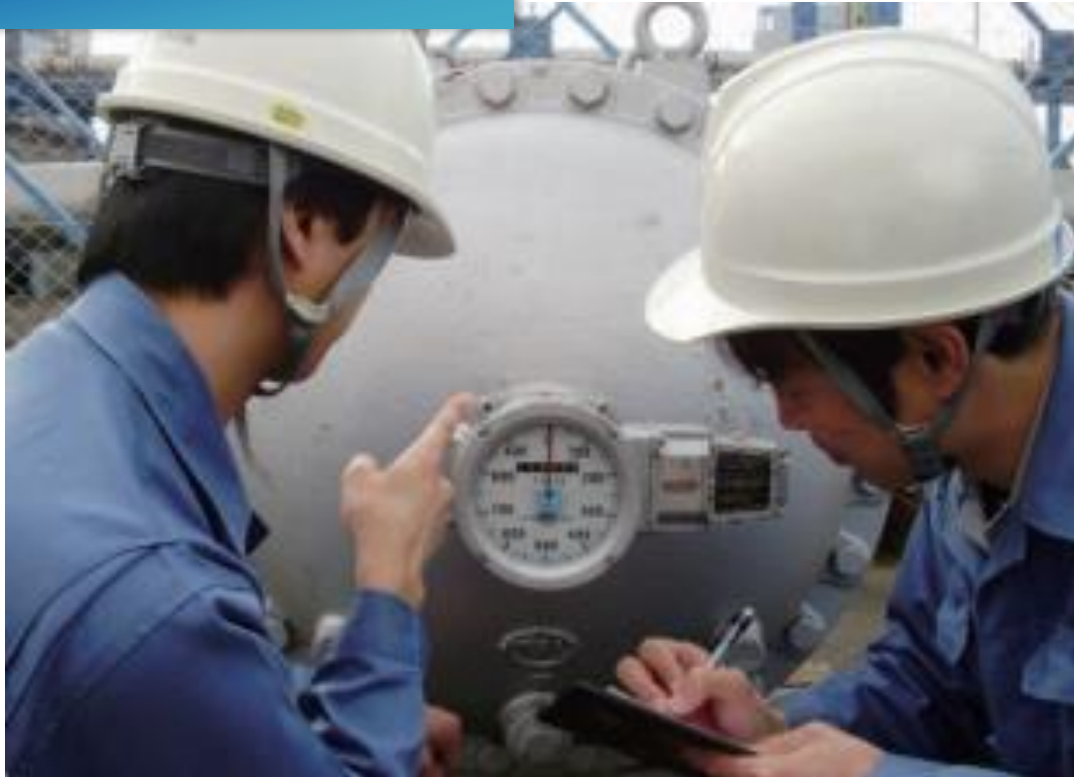
現地での修理・メンテナンス
